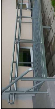
CINKUOTO METALO SURENKAMAS PANDUSAS, TVIRTINIMAS PRIE BETONINIŲ PLYTELIŲ DANGOS (PAPYDYS)
