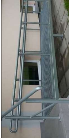
CINKUOTO METALO SURENKAMAS PANDUSAS, TVIRTINIMAS PRIE BETONINIŲ PLYTELIŲ DANGOS (PAVYZDYS)
