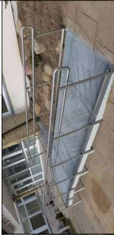
CINKUOTO METALO SURENKAMAS PANDUSAS, TVIRTINIMAS PRIE BETONINIŲ PLYTELIŲ DANGOS (PAVYZDYS)
